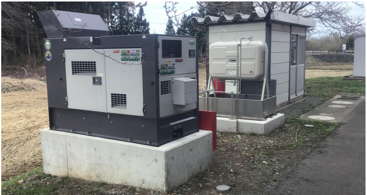
【導入設備】非常用発電機（低圧）とオイルタンク
