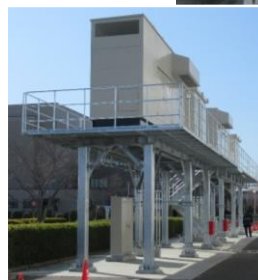
【更新後】 非常用発電機2台（合計1000kVA）
