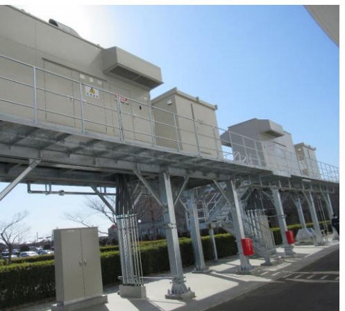
【更新後】 非常用発電機2台（合計1000kVA）
