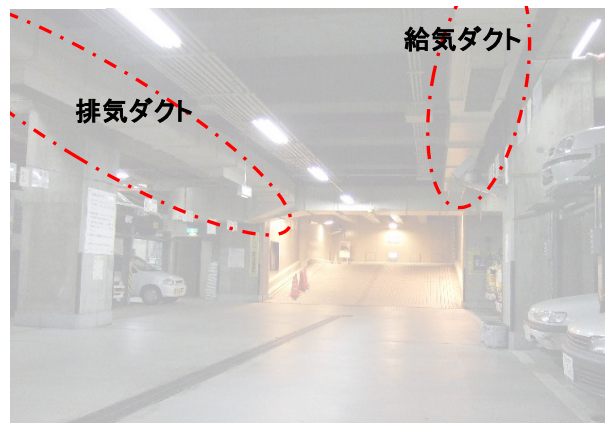
地下駐車場換気設備(例)
