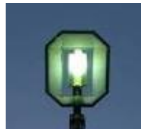
駐車場照明例
