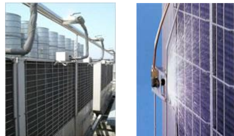
室外機散水装置
