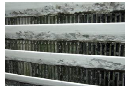
冷却塔充填材の汚れ
