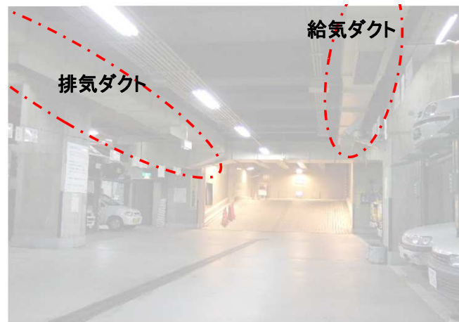
地下駐車場換気設備(例)
