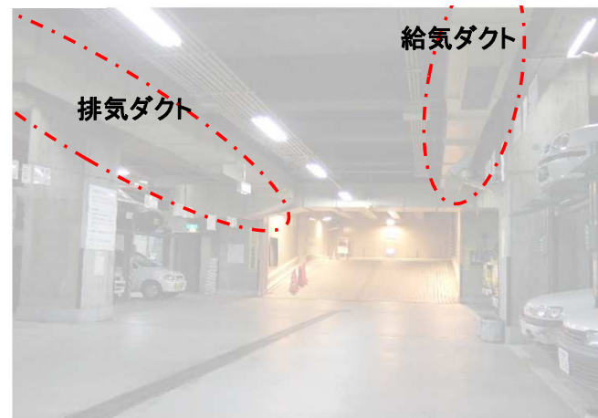
地下駐車場換気設備(例)
