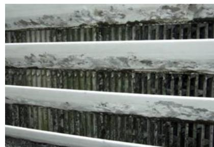
冷却塔充填材の汚れ
