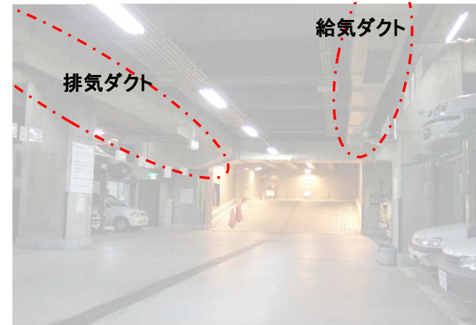
地下駐車場換気設備(例)
