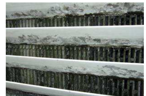
冷却塔充填材の汚れ
