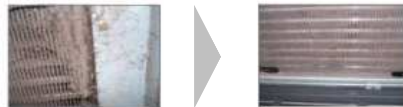
熱交換器フィン洗浄前後の状況
