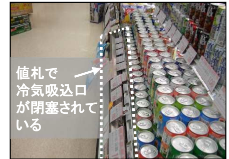
値札による冷気吸込口閉塞
