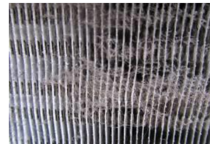
エアコン室外機の裏側の空気吸い込みフィン
