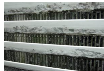
冷却塔充填材の汚れ
