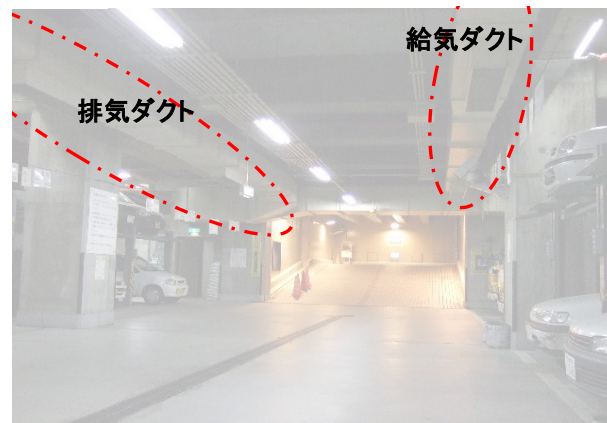
地下駐車場換気設備(例)
