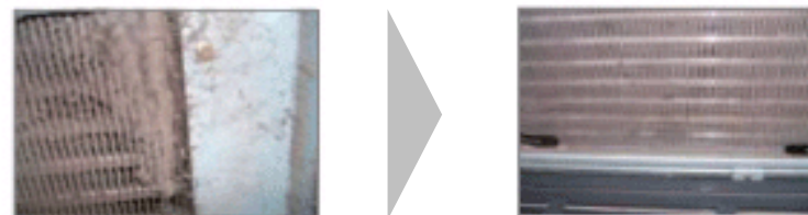
熱交換器フィン洗浄前後の状況
