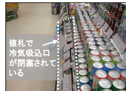
値札による冷気吸込口閉塞
