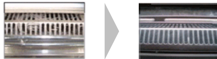
吸込口洗浄前後の状況
