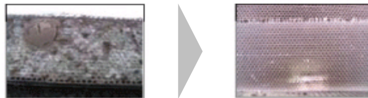
吹出口洗浄前後の状況
