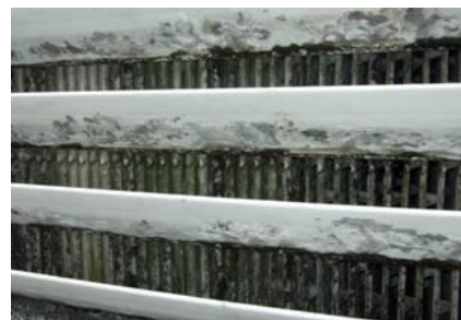
冷却塔充填材の汚れ
